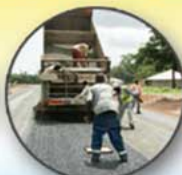
Aménagement de chaussées
